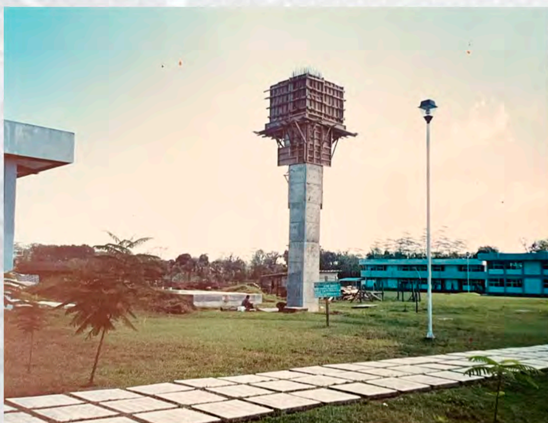
FOTO: ARCHIVO UPCH/ VISTA DE LA CONSTRUCCIÓN DEL TANQUE ELEVADO DE LA UPCH
