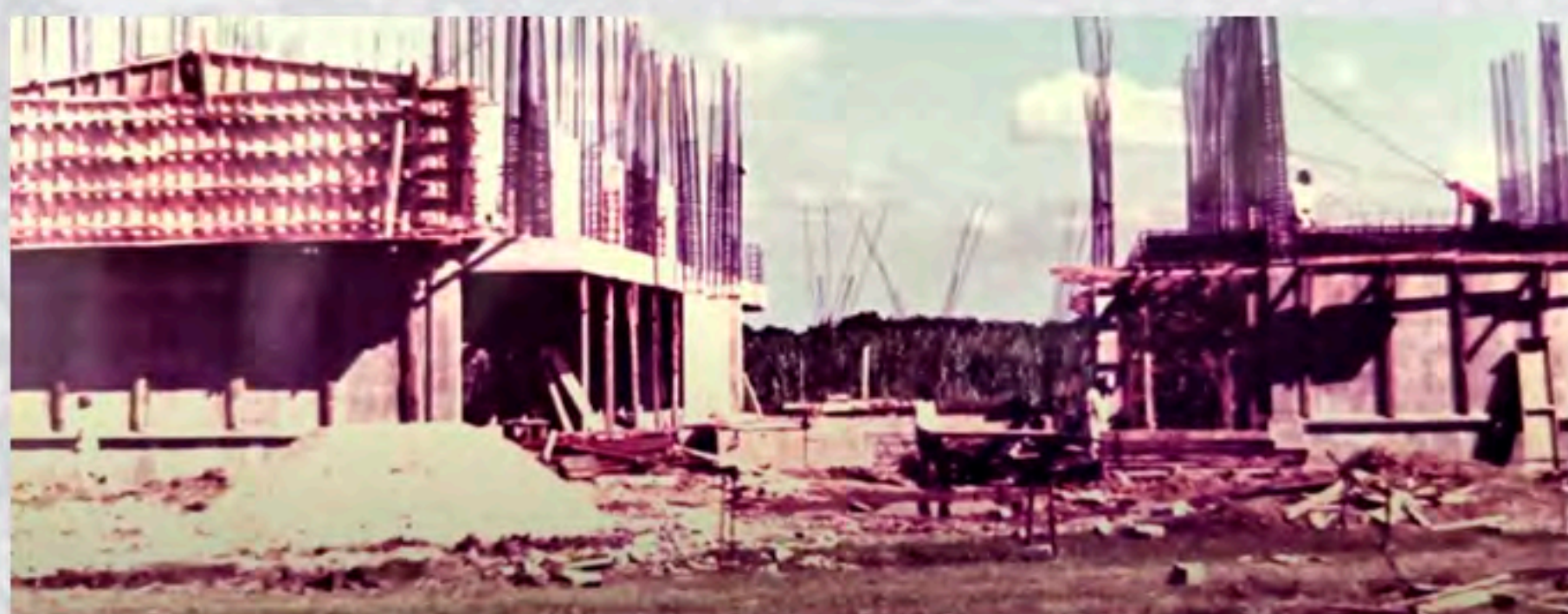
PRIMERA INFRAESTRUCTURA EDIFICIO "A"
