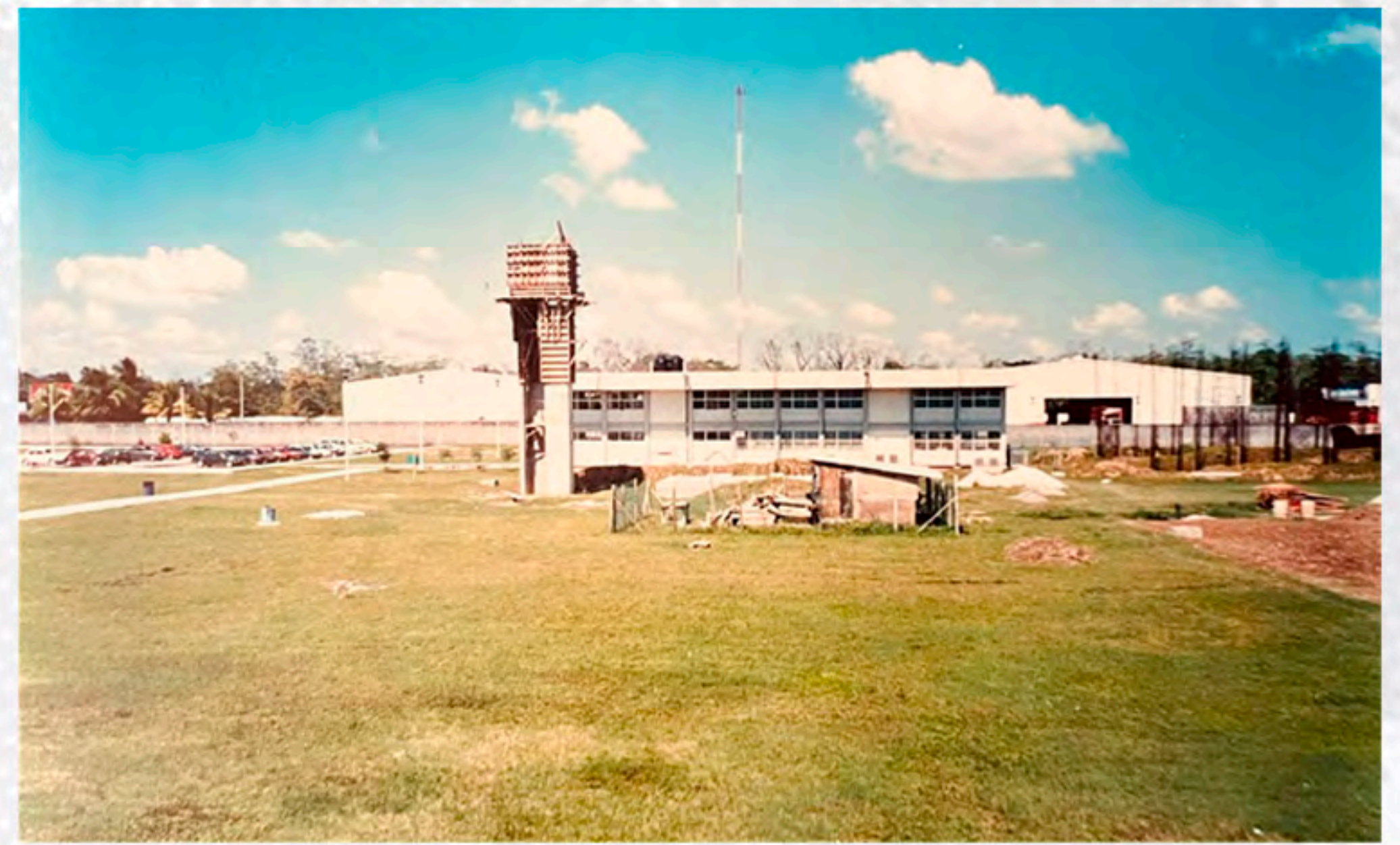
FOTO: ARCHIVO UPCH/ CONSTRUCCIÓN DEL EDIFICIO "A"
