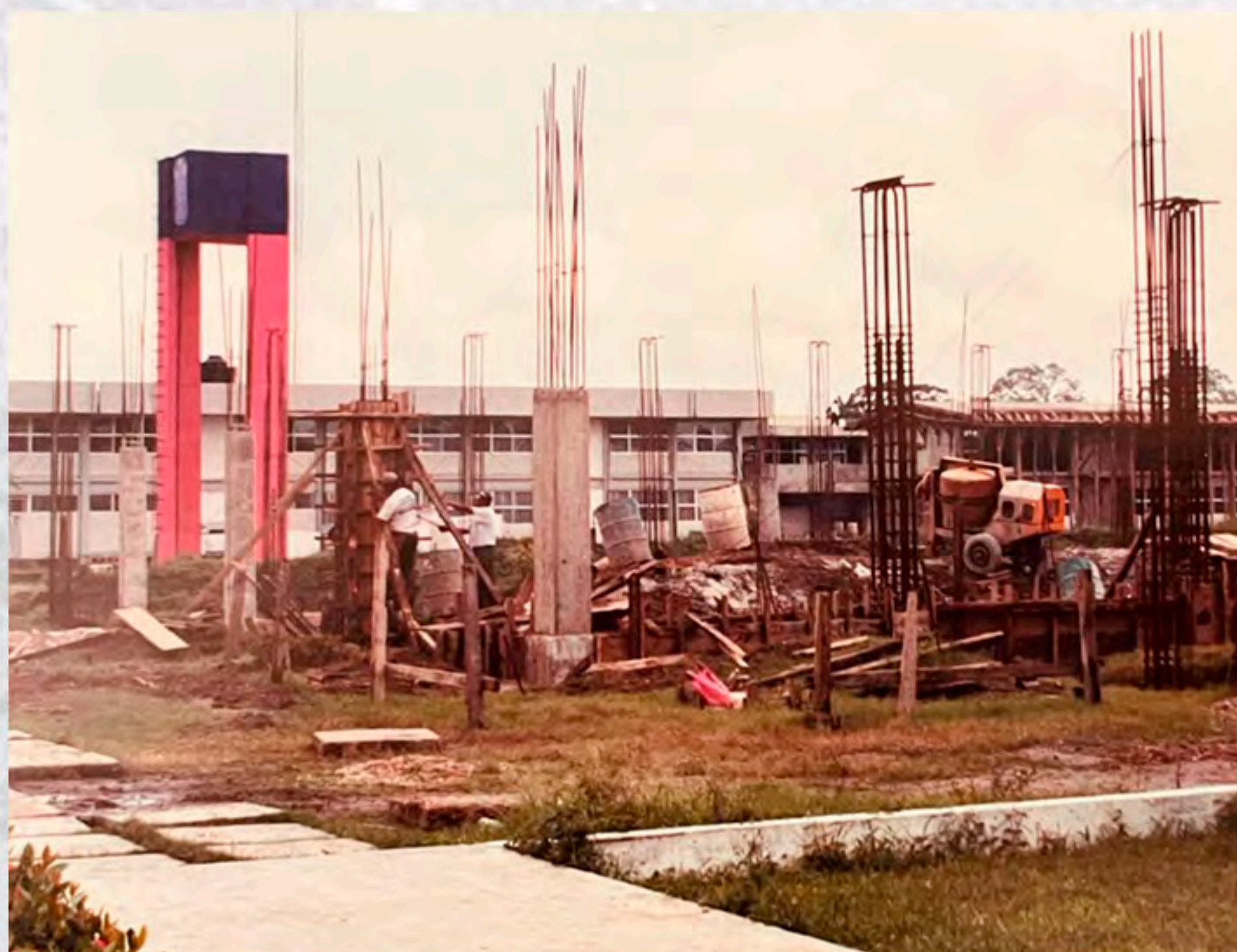
FOTO: ARCHIVO UPCH/CONSTRUCCIÓN DEL AUDITORIO GIMNASIO O AUDITORIO "A"
