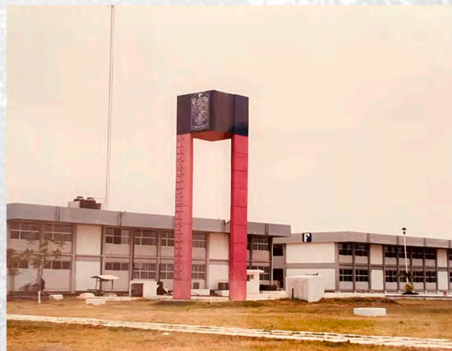
FOTO: ARCHIVO UPCH/TANQUE ELEVADO DE LA UPCH
