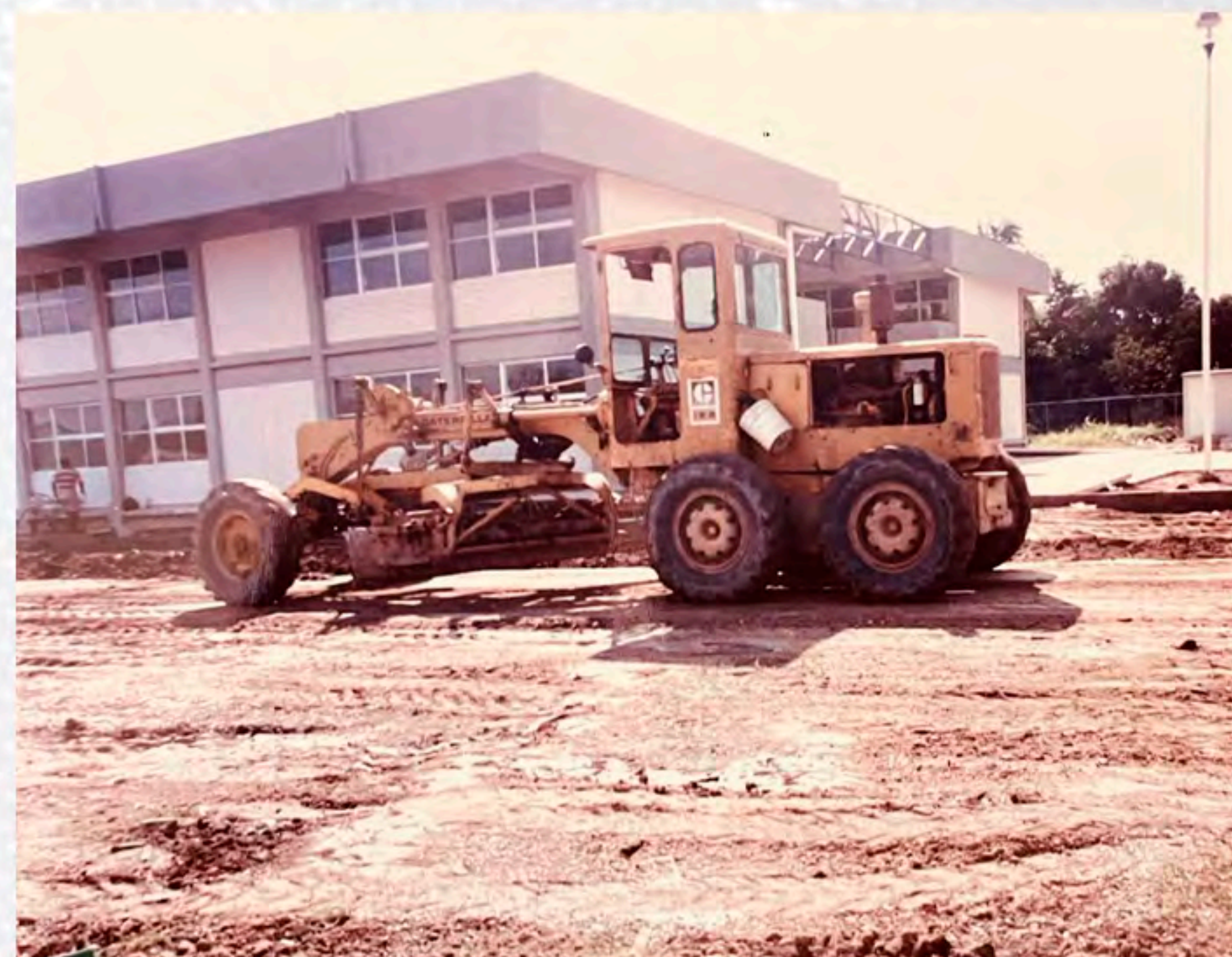
FOTO: ARCHIVO UPCH/TRABAJOS DE CONSTRUCCIÓN A UN LADO DEL EDIFICIO "B"
