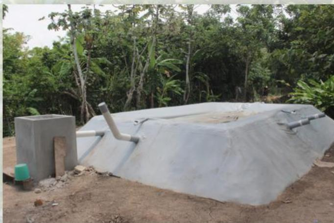
“Biodigestor” construido en las instalaciones de la UPCH
